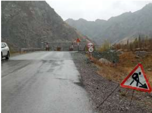
Мост №14. Дорожные знаки
