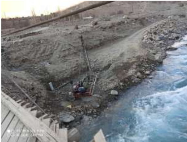
Мост №3. Бутонабивные работы
