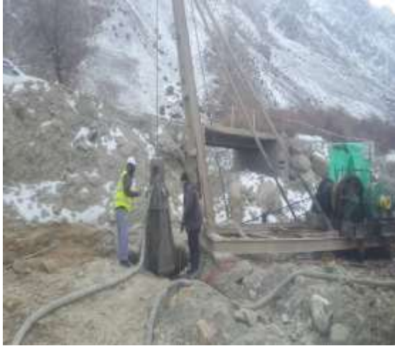
Мост №8. Буронабивные работы
