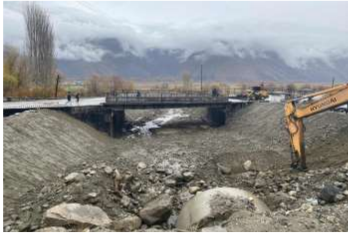
Мост №9. Укрепление откоса
