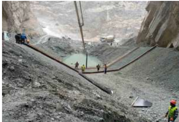
Мост №15. Укрепление верхнего русла
