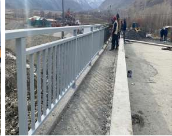
Мост №9. Окраска перильных ограждений
