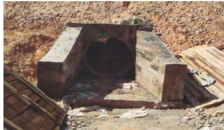
Кабадиян. Строительство трубоперезда
