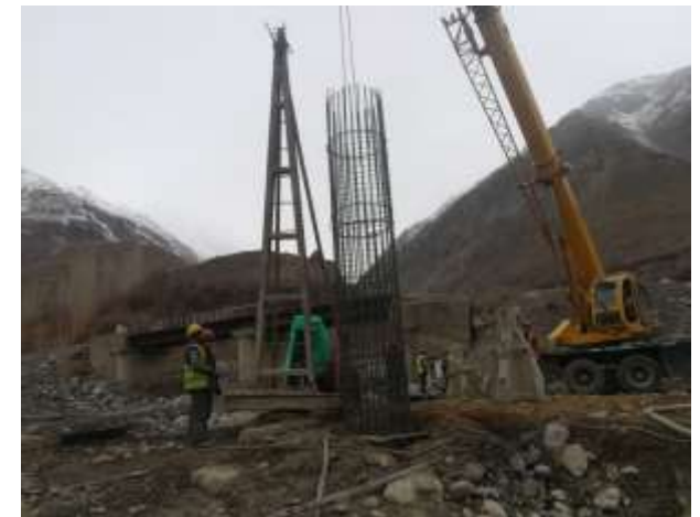
Мост №7. Бетонирование свай
