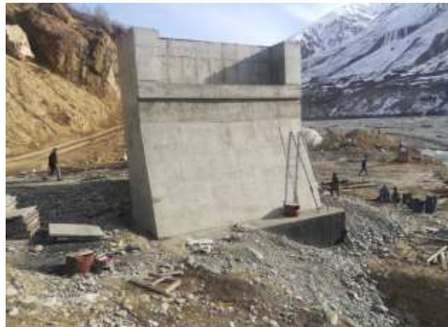
Мост №6. Завершенная опора
