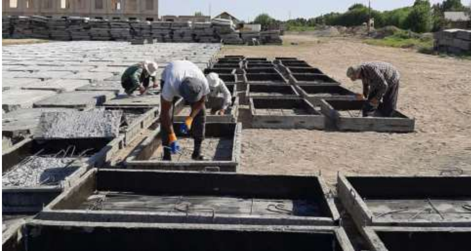
Кабадиян. Процесс изготовления железобетонных плит.
