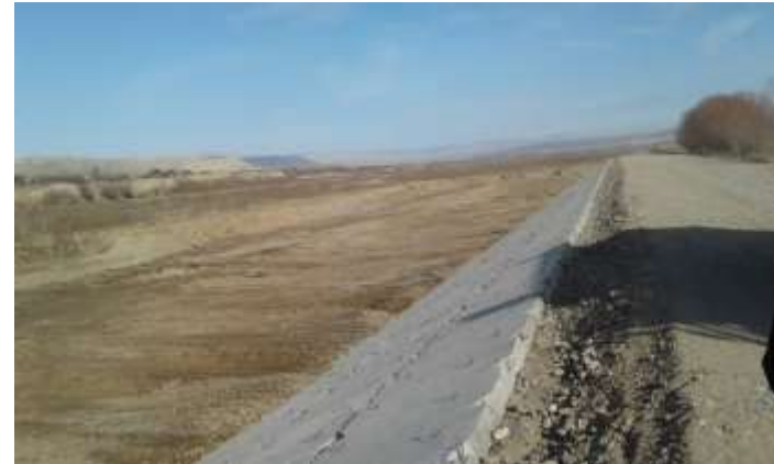
Вид дамбы после завершения строительства
