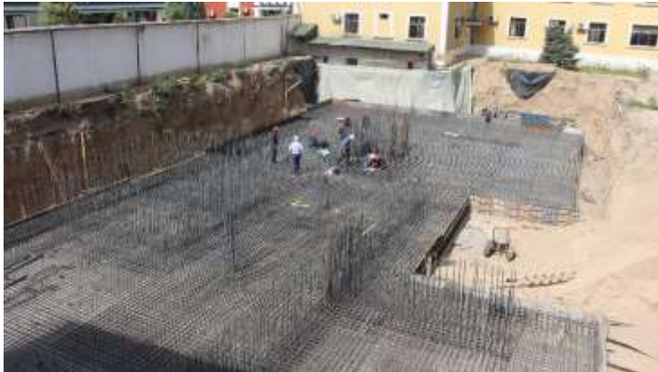
Процесс армирования фундаментной части здания НЦУКС
