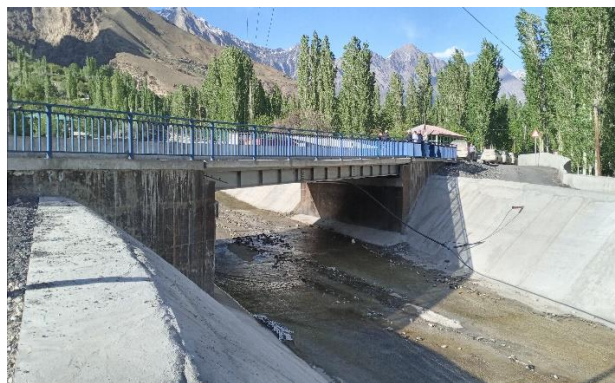
Мост №9, Рушанский район
